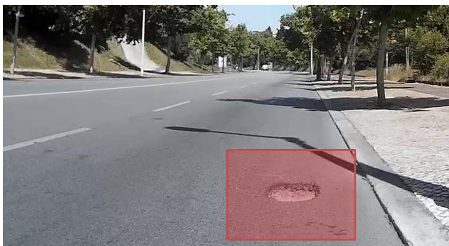
Figura 3.2.3 – Buraco na via detectado pelo sistema desenvolvido.
