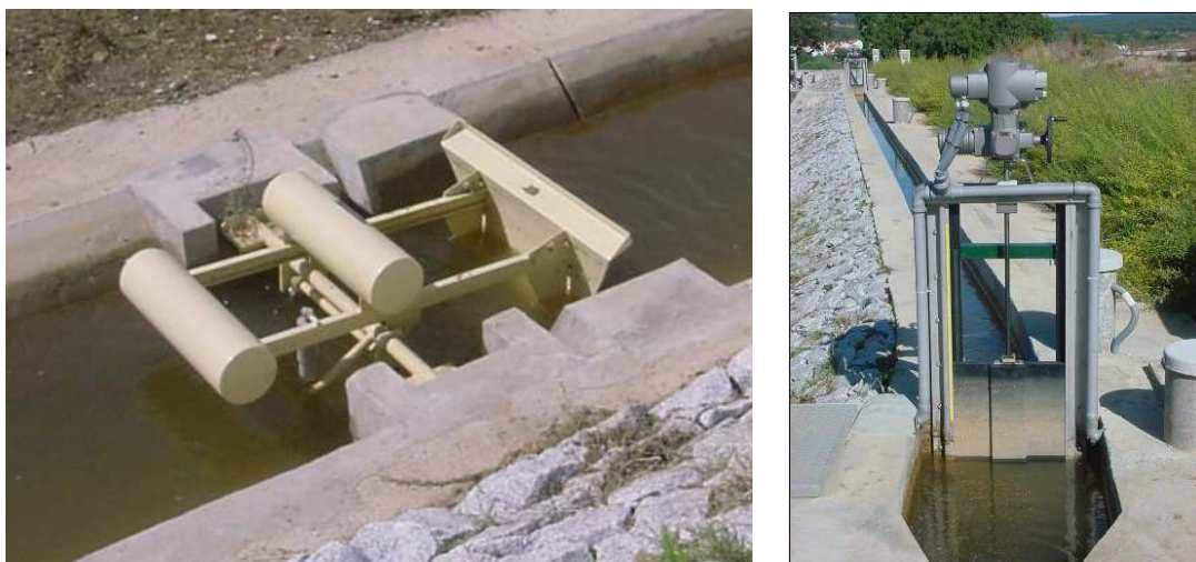
Figura 1.1: O presente contra o futuro. Comportas: hidráulicas (AMIL) Vs motorizadas
